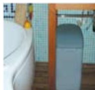
salle de bains (sans électricité)
